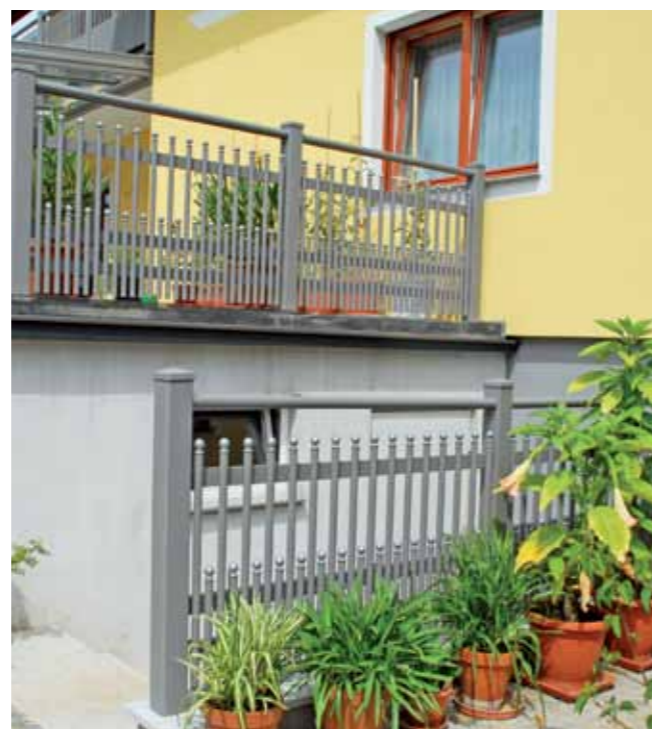
Bild 56-04: Gloriette Geländer, Handlauf Comfort darüber
