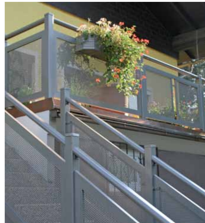
Bild 72-04: Loskana 2 Balkon, Geländer Sonderkonstruktion
