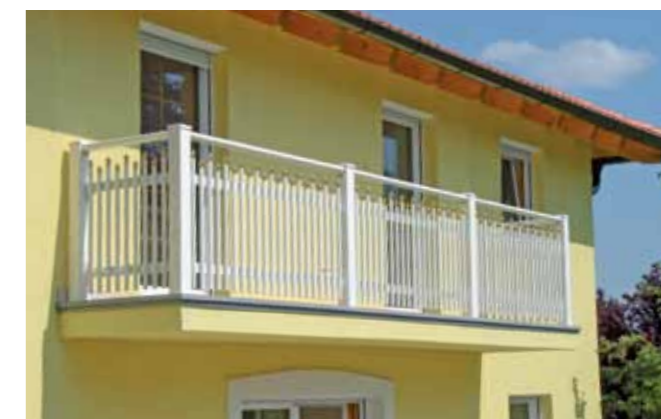
Bild 57-04: Gloriette Geländer, Handlauf Comfort darüber
