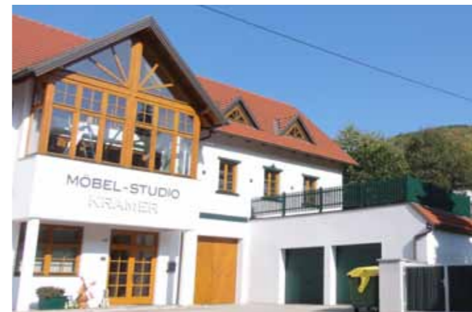
Bild 15-02: Merlin Balkon ohne Handlauf
